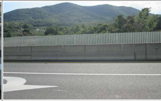
상행선 S1 중분대 콘크리트 박락 보수 현황
