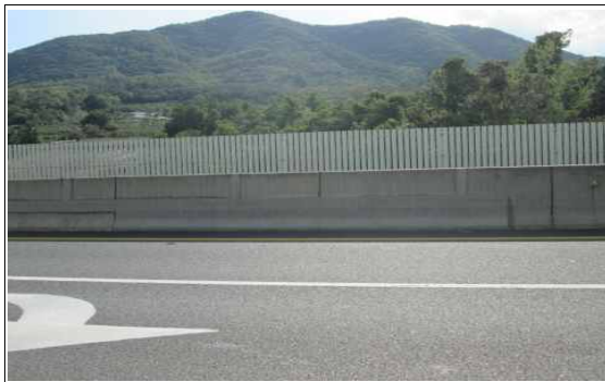
상행선 S3 중분대 콘크리트 박리 보수
